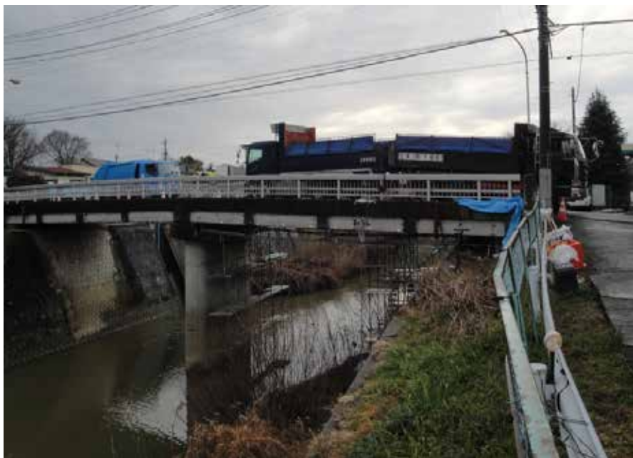
載荷状況 (第2径間)
