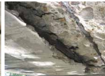
主筋の腐食
