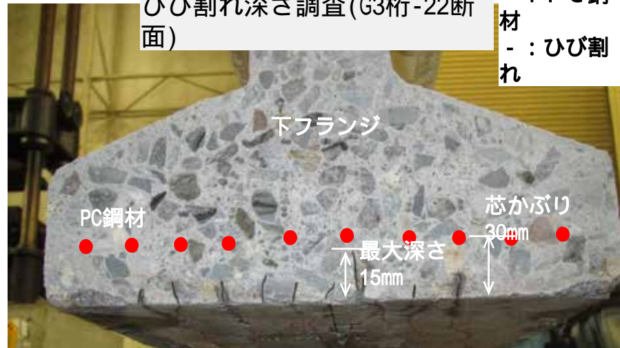
中性化深さ調査(G3桁-22断面)
