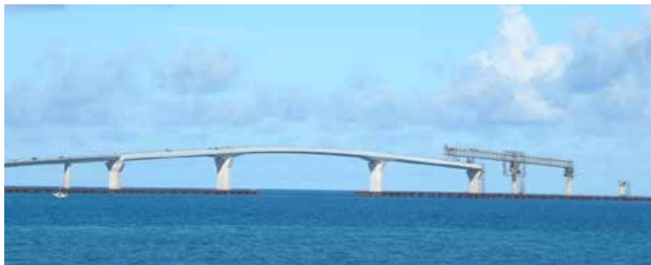
現在建設中の伊良部大橋
