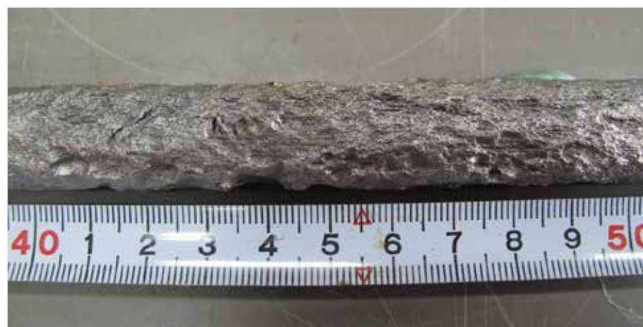
孔食が見られる腐食
