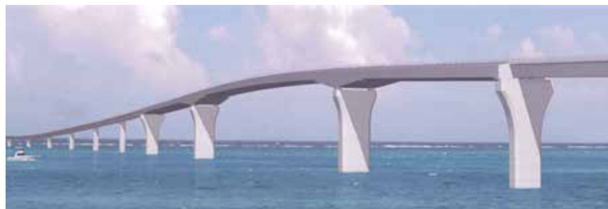
新設橋(伊良部大橋)
