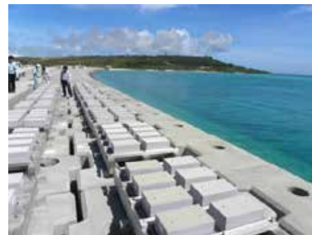
現地暴露供試体(181体) 実際の下部工に使ったコンクリートと 同じ材料・同じ配合
