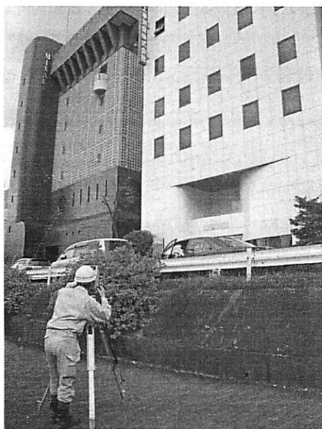
写真2 外部からの調査の様子
