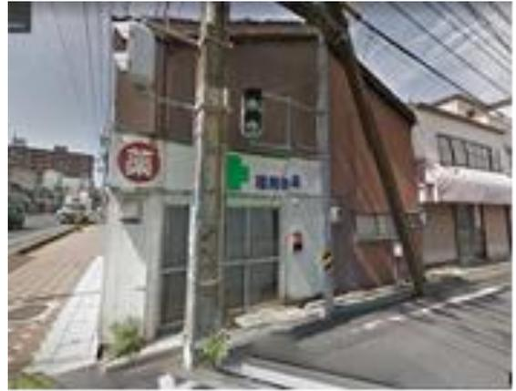
この電柱は、H形錐状の本柱と矩形の控え柱・中段梁から構成されたプレキャストコンクリート製であり高さは約11mです。H形錐の基部の大きさは地表部で約0.4m×0.3m、控え柱は0.19m×0.19mです。地盤面から1mのところの名盤が打ち込まれており、製造は昭和30年代と確認できます。
