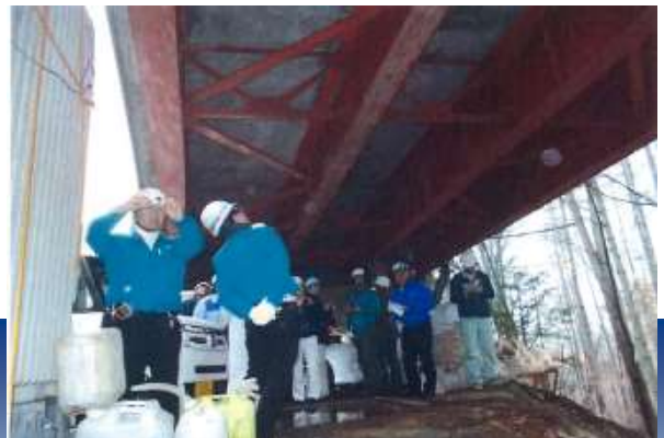
③高速道路の補修・補強工事見学
