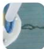
注入状況 確認
