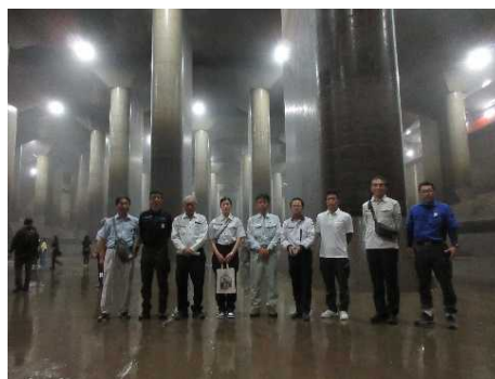
龍Q館「外郭放水路」
